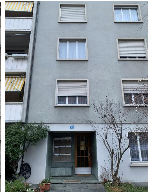
MFH Lehenmattstrasse, Basel
